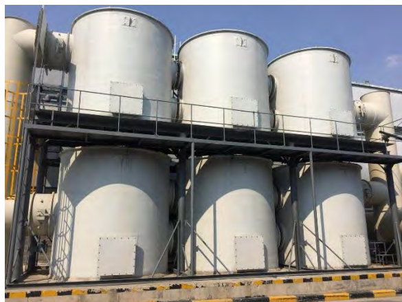
PECVD 工序废气治理装置
