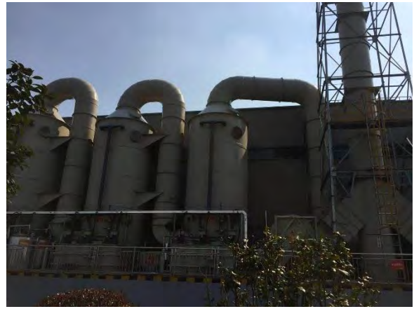
扩散工序废气治理装置
