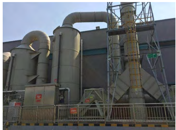
PECVD 工序废气治理装置
