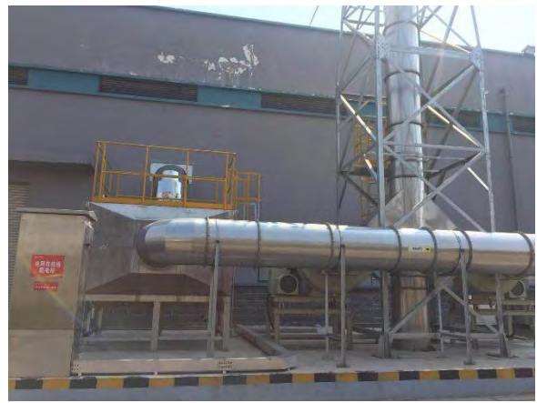
组件 M2 生产废气治理装置（共两套）
