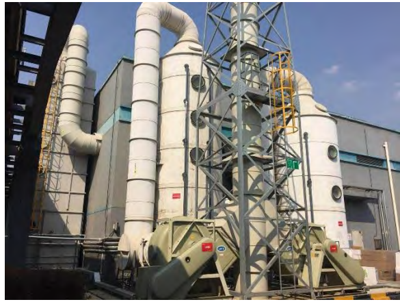
扩散工序废气治理装置
