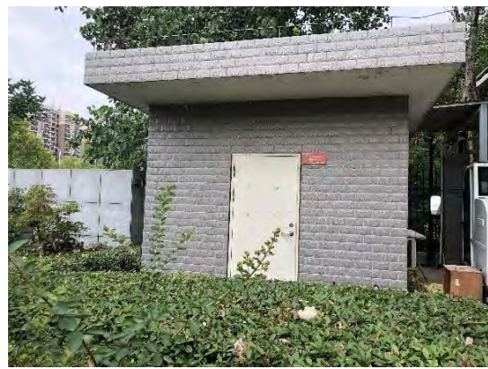
公司东大门在线监测室
