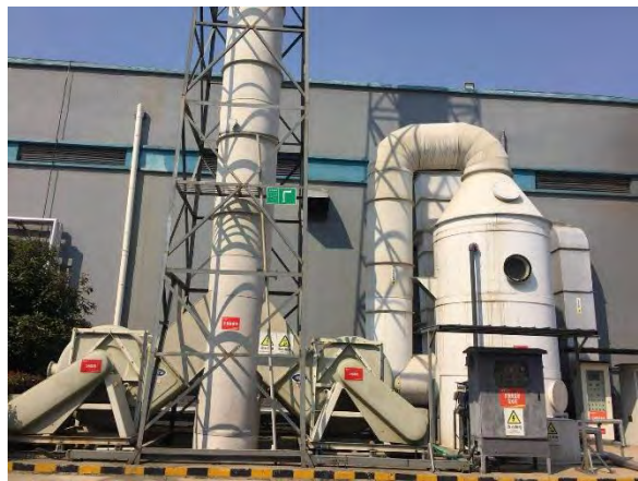
刻蚀、清洗工序废气治理装置
