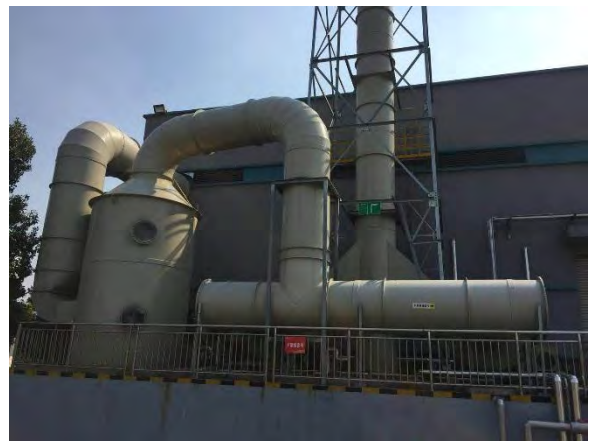
刻蚀、清洗工序废气治理装置
