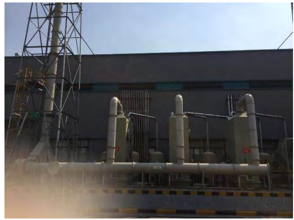
丝网印刷工序废气治理装置
