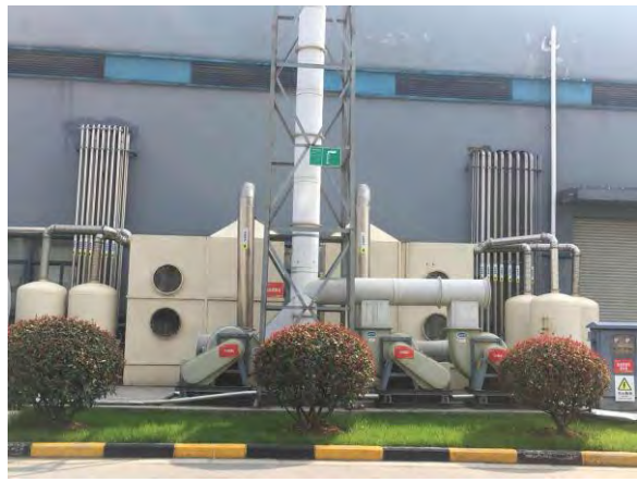
丝网印刷工序废气治理装置
