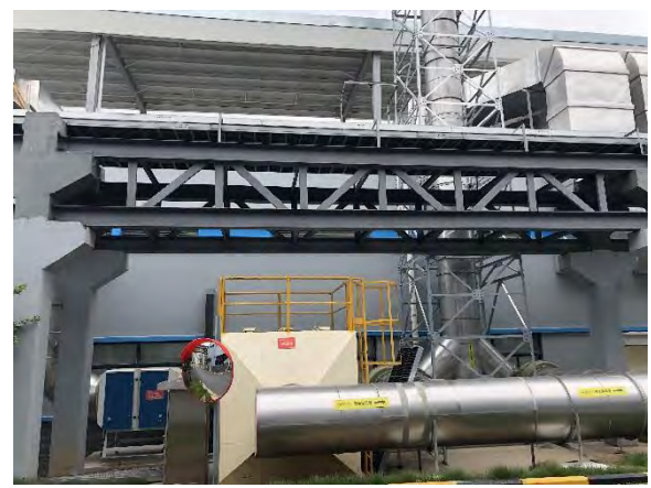
污水处理站处理装置及排气筒
