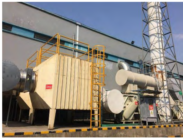
组件 M1 生产废气治理装置（共一套）
