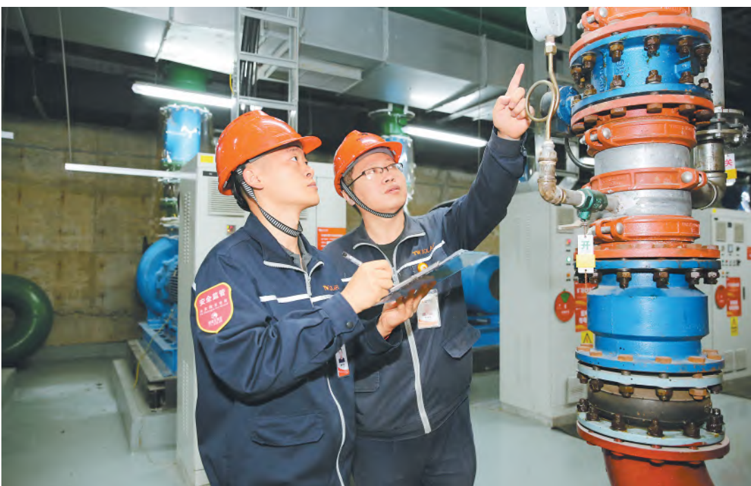
检查地下水泵房消防管网水压
