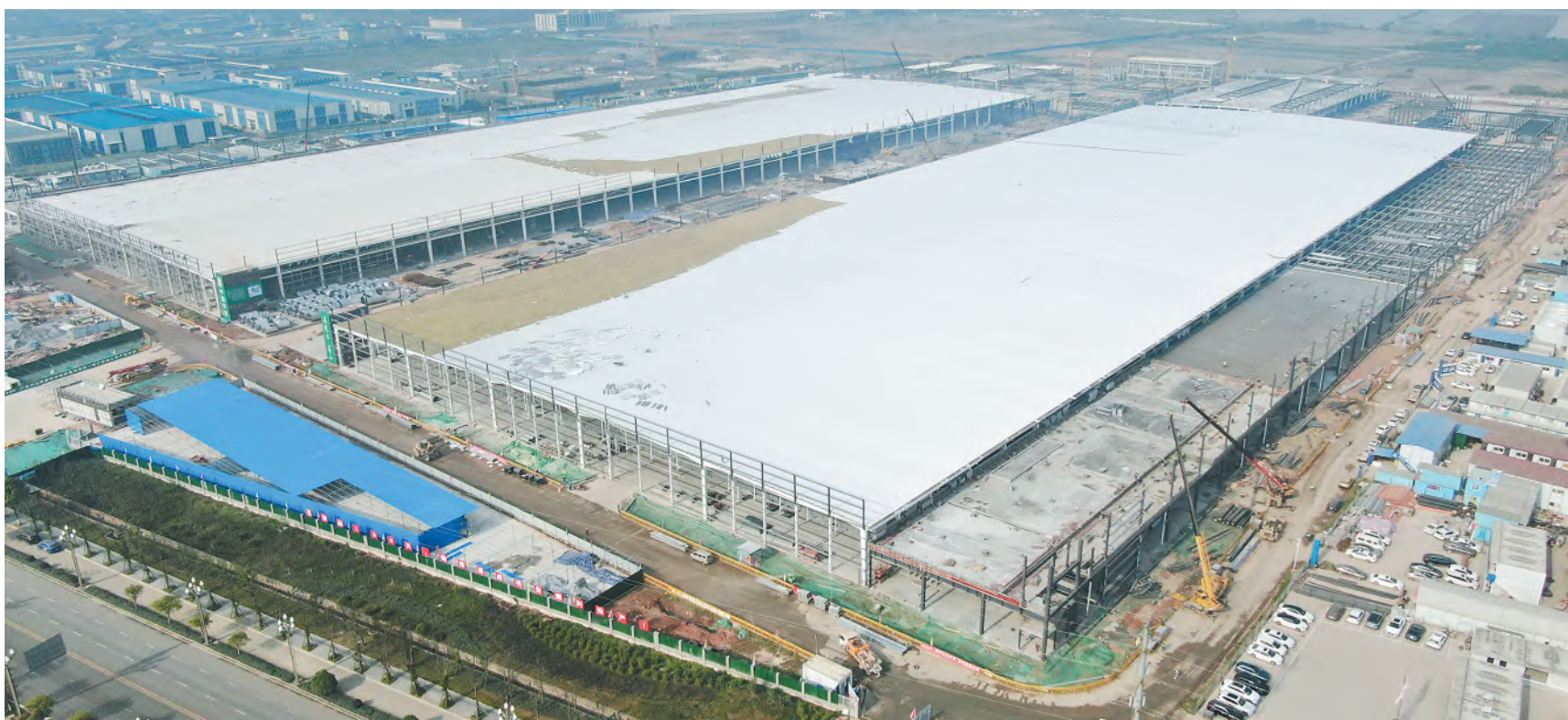
3月30日,通威太阳能眉山基地一期项目全面封顶
