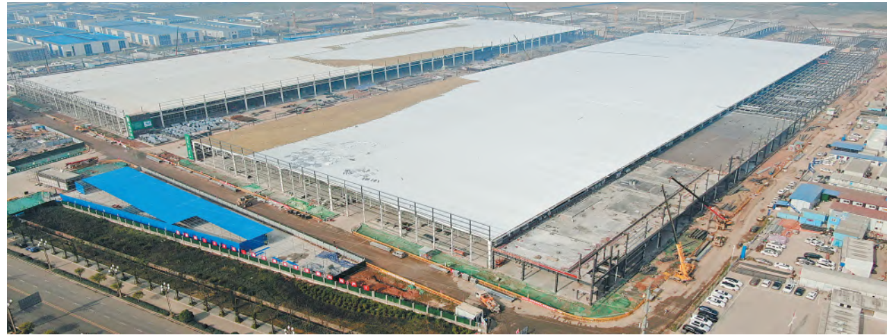
2023年4月,建设中的通威太阳能彭山基地
