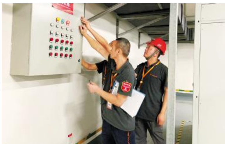
成都基地开展电气安全专项检查
