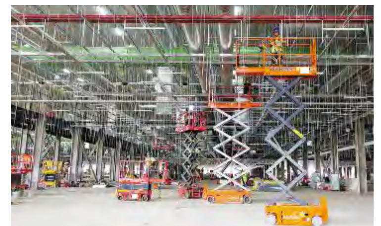
合肥基地新项目建设如火如荼
