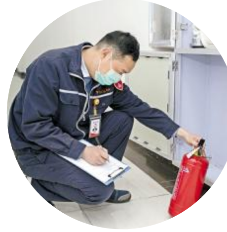
曾凯进行消防栓点检
