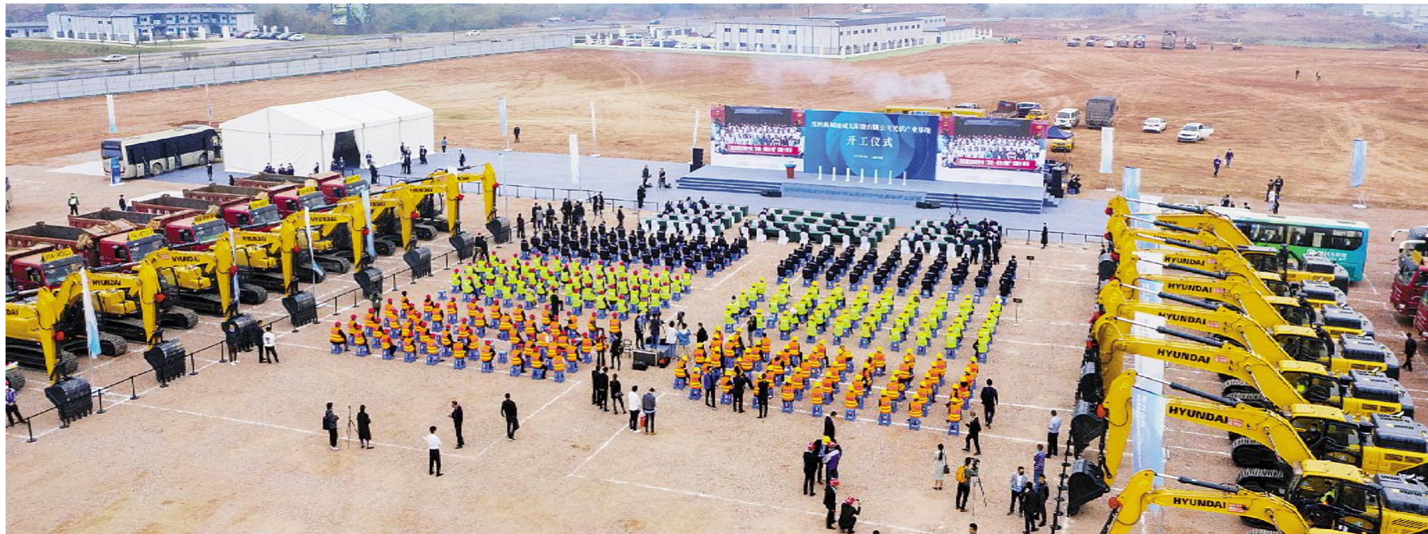
开工仪式现场
