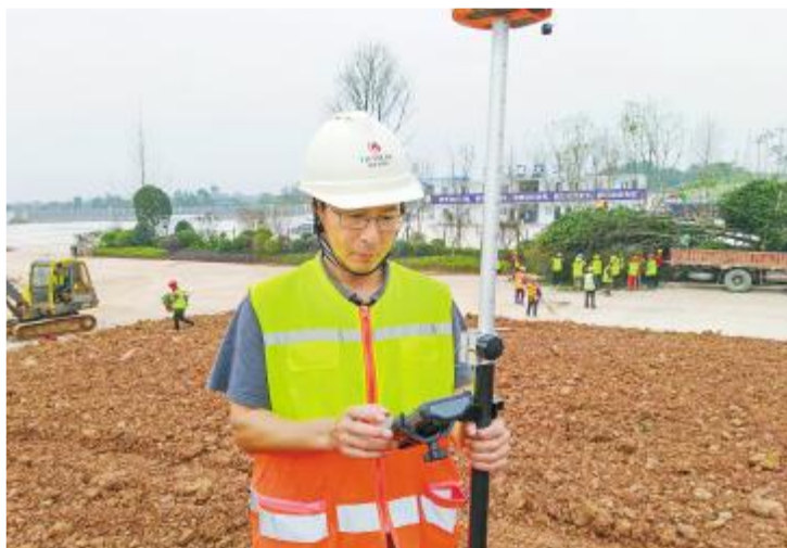
张凌用GPS测量绿化土方
