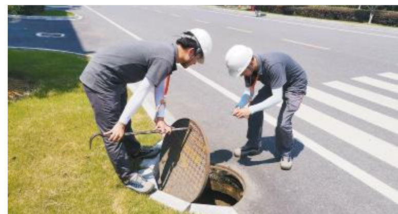
合肥基地员工排查排水通道
