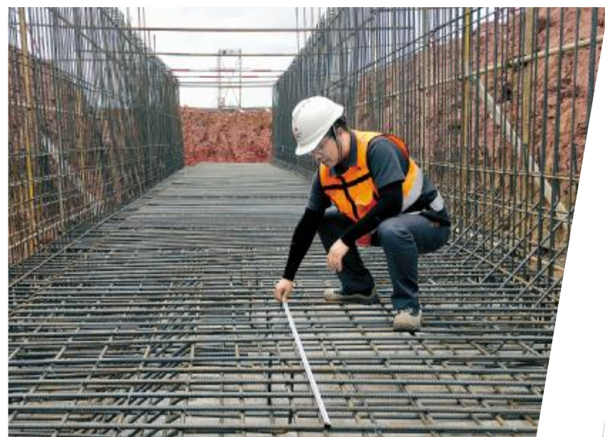
薛磊在项目上检查管沟钢筋绑扎情况
