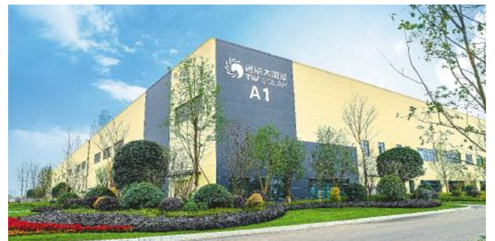
通威太阳能成都三期A1车间
