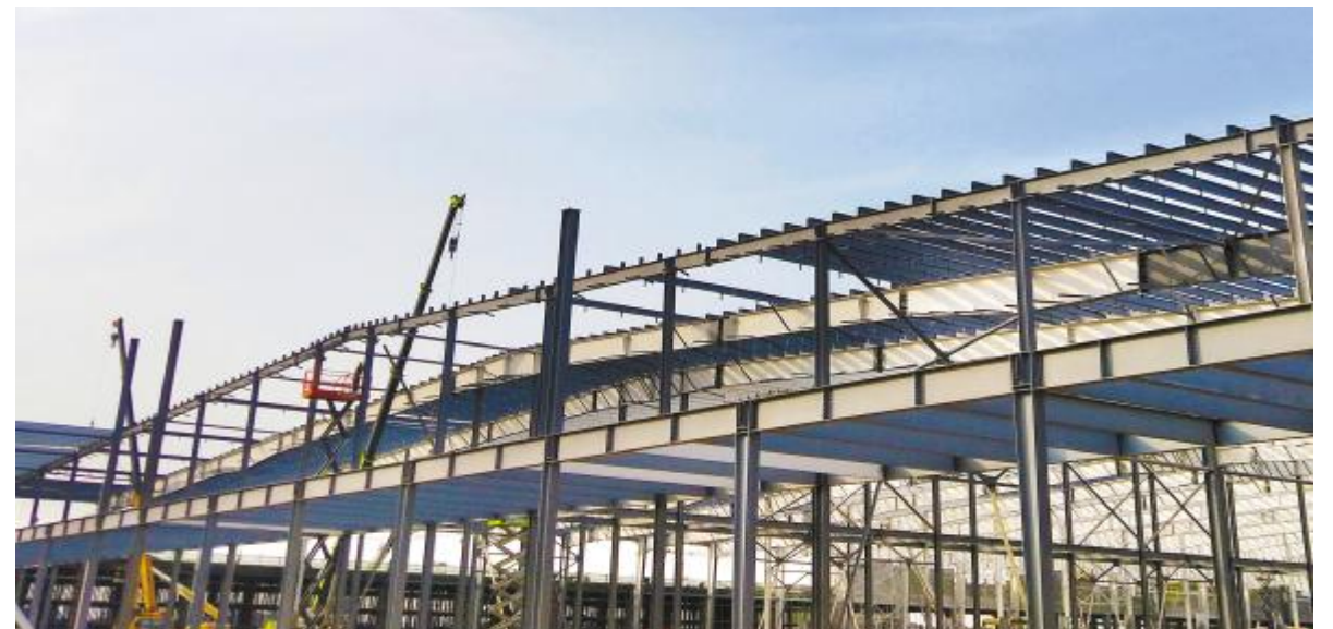
通威太阳能眉山公司建设现场
