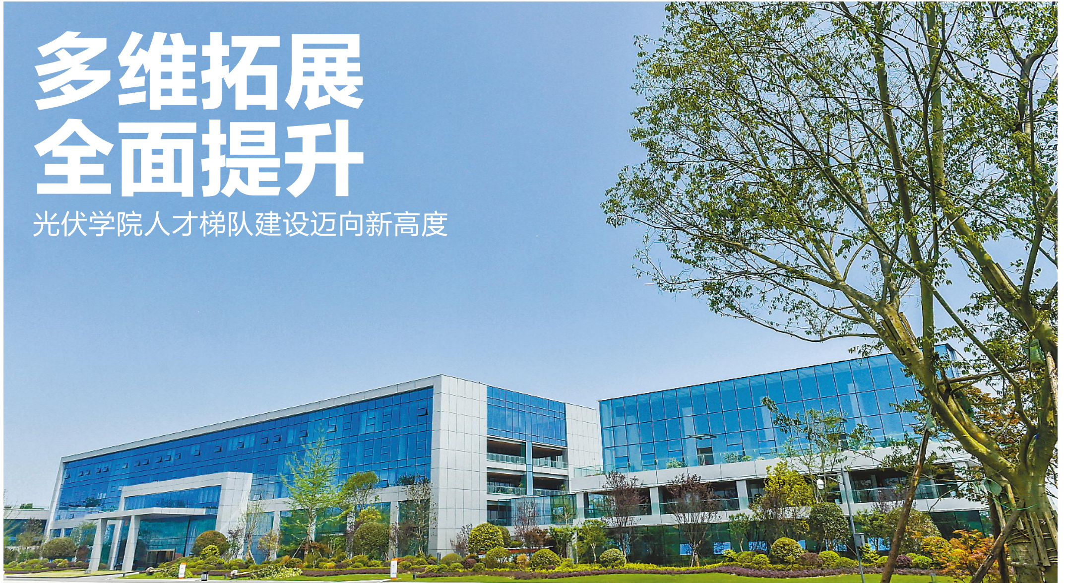
生机勃勃的通威太阳能成都公司厂区
