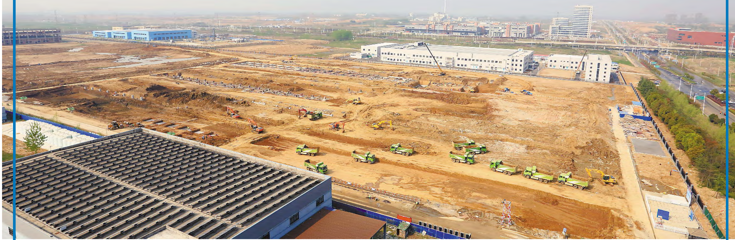
通威太阳能安徽公司一期工程建设现场
