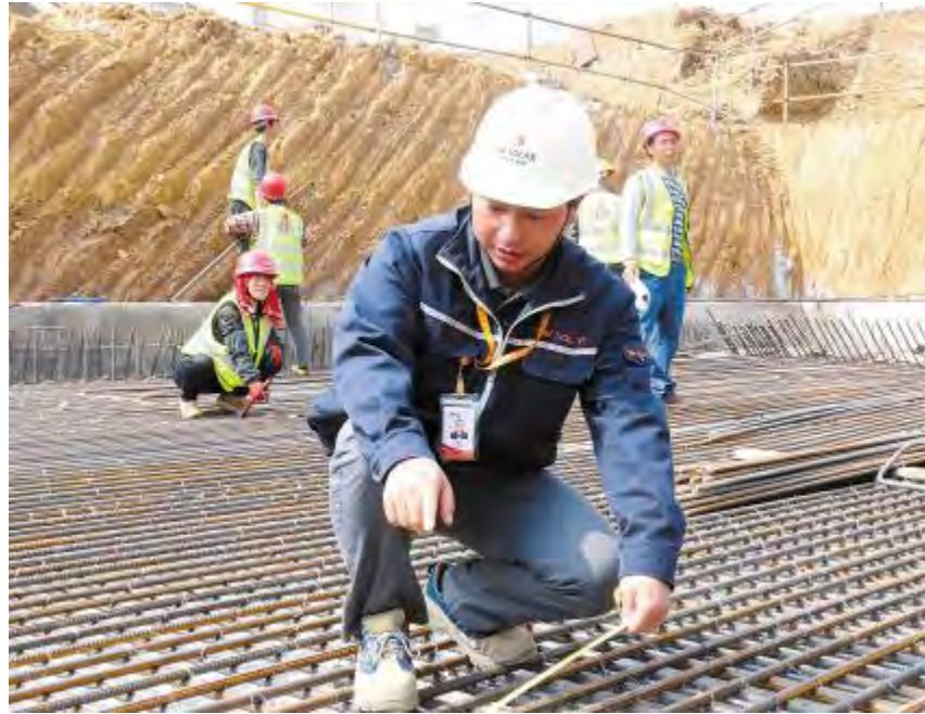
张飞对安徽一期工地基建钢筋进行测量
