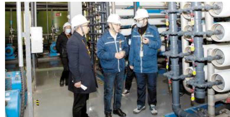
合肥基地安全大检查现场
