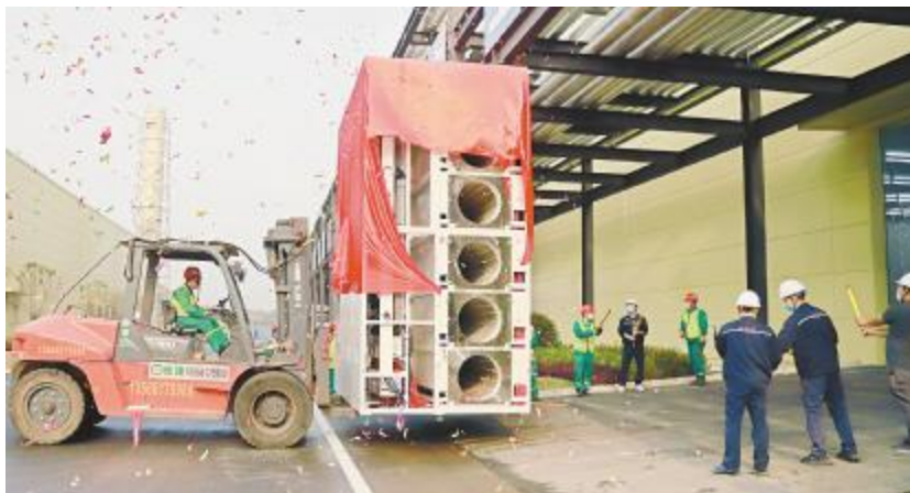
通合新能源电池项目二期设备进场
