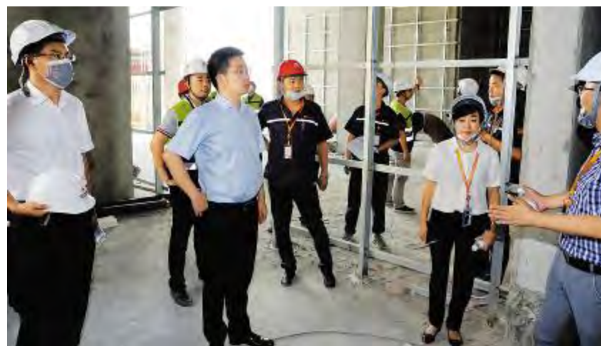
谢毅董事长在二期项目现场看望高温作业员工,详细询问项目建设相关情况
