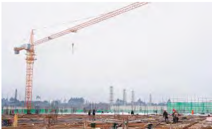
二期项目建设现场
