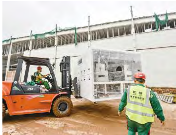
成都基地三期项目大型设备正在进场
