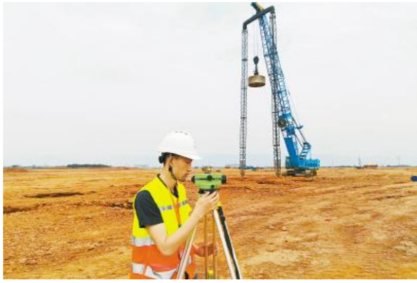
金堂公司工程部员工高瞻测量地面夯实后标高
